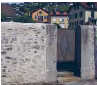
Réfection des murs de vigne à Lavaux (en page 8)
